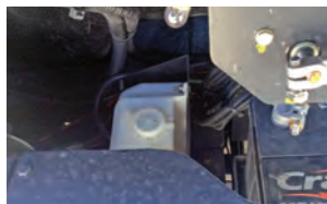
Detalhe do reservatório de água
