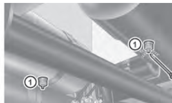
Drenagem manual dos reservatórios pneumáticos (exemplo)
