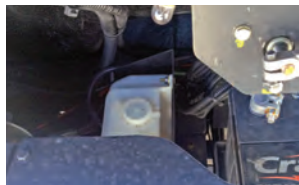
Detalhe do reservatório de água
